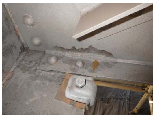
写真4-20 鋼材補修工 施工状況（ブラスト後）
