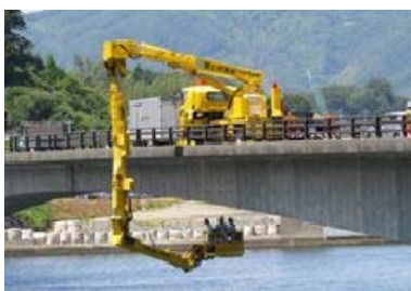
写真2-1 橋梁点検状況
