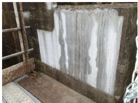
写真4-12 断面修復工 完成
