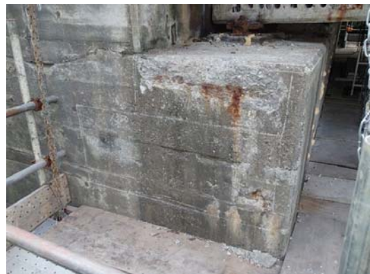
写真4-10 断面修復工 施工前
