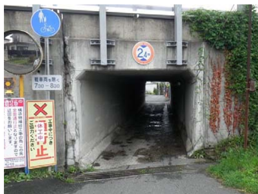
写真4-31 補修工 施工前
