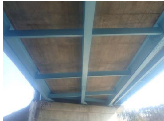
写真4-9 横桁補修工 完成
