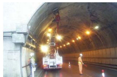
写真2-2 トンネル点検状況
