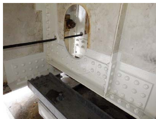
写真4-3 鋼桁補修工 完成
