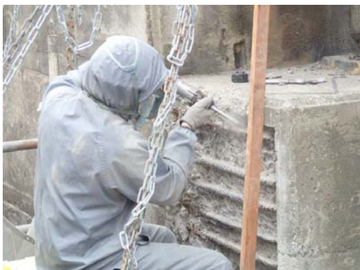
写真4-11 断面修復工 施工状況
