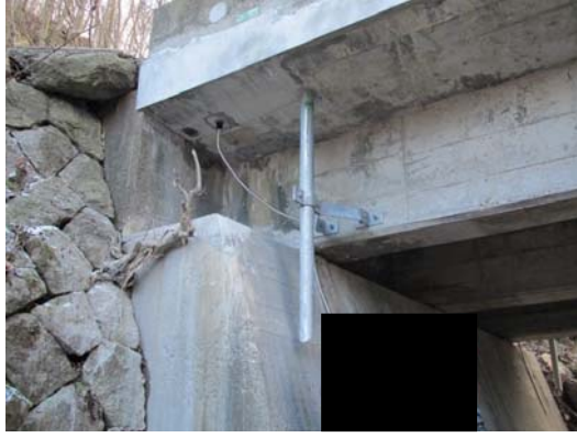
写真4-18 排水管補修工 完成
