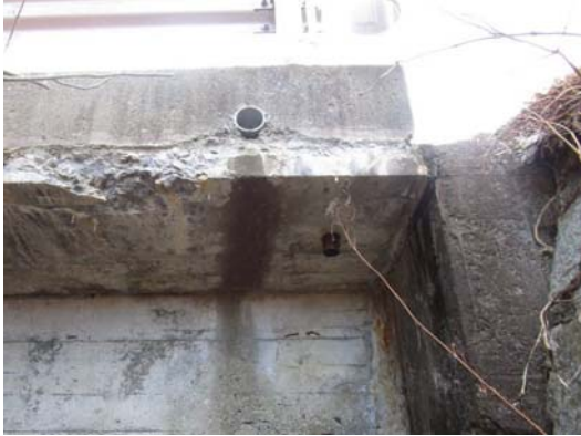
写真4-16 排水管補修工 施工前
