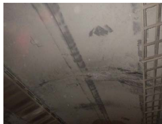
写真4-22 断面修復工 着手前
