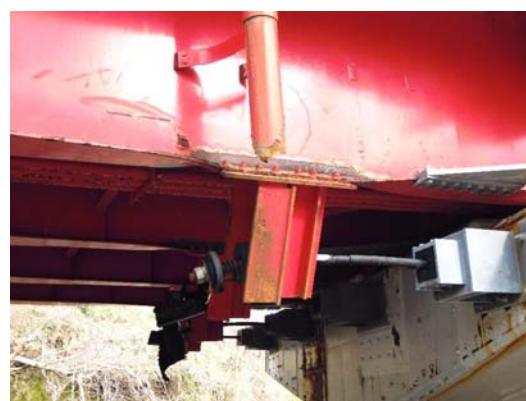
写真4-4 鋼桁補修工 施工前
