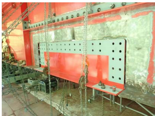
写真4-5 鋼桁補修工 施工状況
