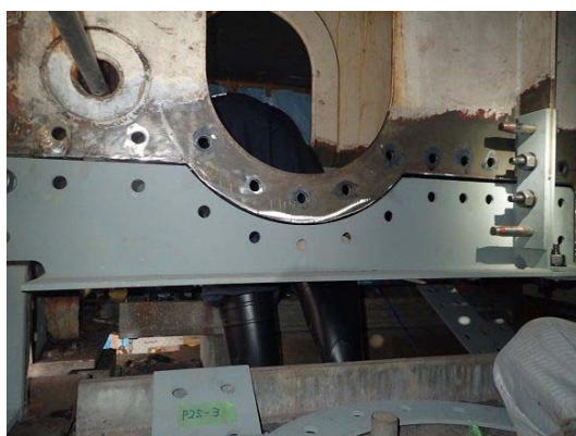
写真4-2 鋼桁補修工 施工状況
