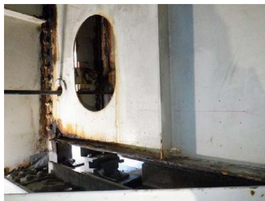
写真4-1 鋼桁補修工 施工前
