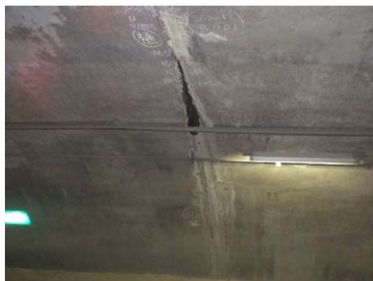
写真4-25 面導水工 着手前
