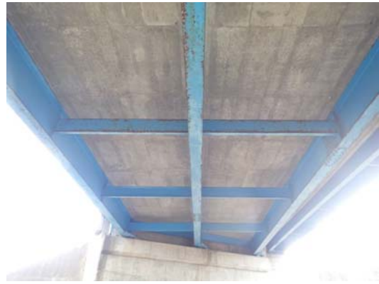
写真4-7 横桁補修工 施工前
