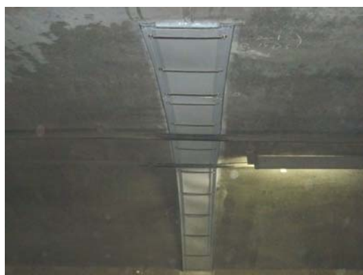
写真4-27 面導水工 完成
