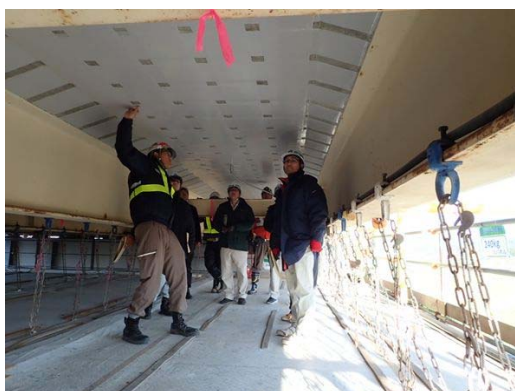
写真5-1 橋梁補修工事現地講習会・現場見学
