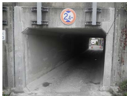
写真4-33 断面修復工 完成
