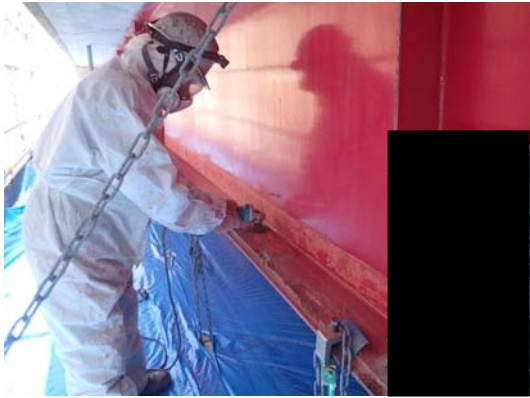
写真4-14 塗装塗替え工 ケレン状況
