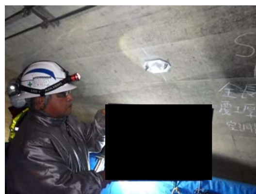
写真4-28 注入工施工前（削孔後）
