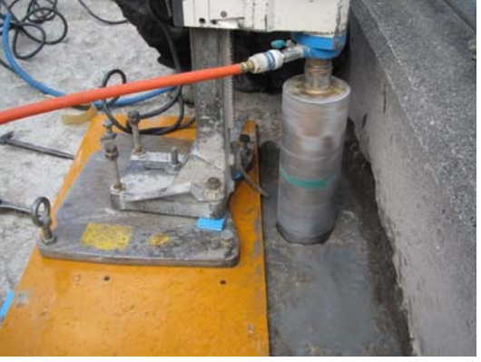
写真4-17 排水管補修工 削孔状況
