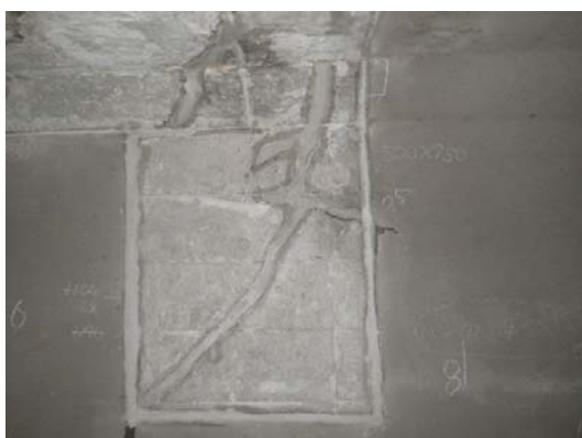
写真4-32 ひびわれ補修工 完成
