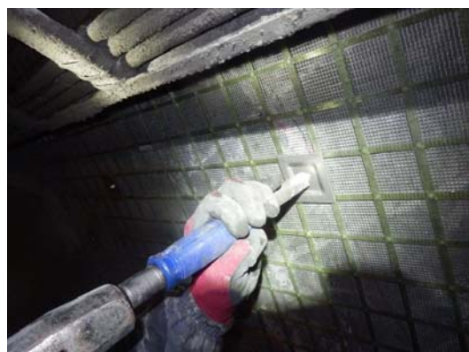
写真4-23 断面修復工 施工状況
