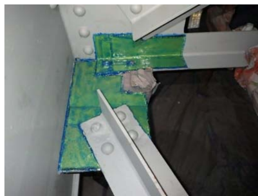
写真4-21 鋼材補修工 完成 （この上から塗装）
