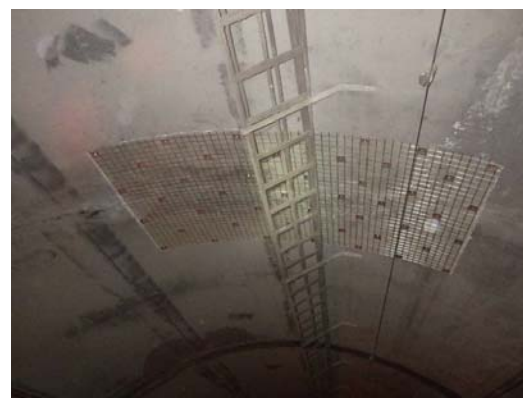
写真4-24 断面修復工 完成
