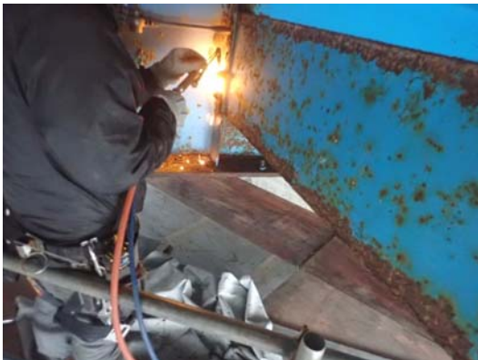
写真4-8 横桁補修工 施工状況
