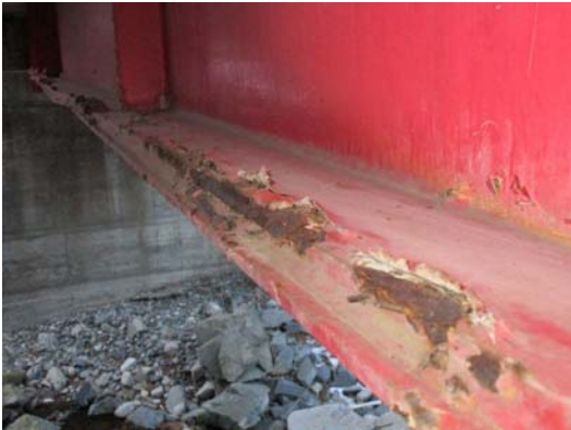
写真4-13 塗装塗替え工 施工前
