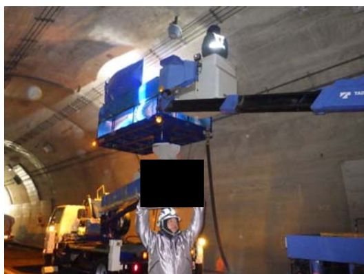
写真4-29 注入工施工中
